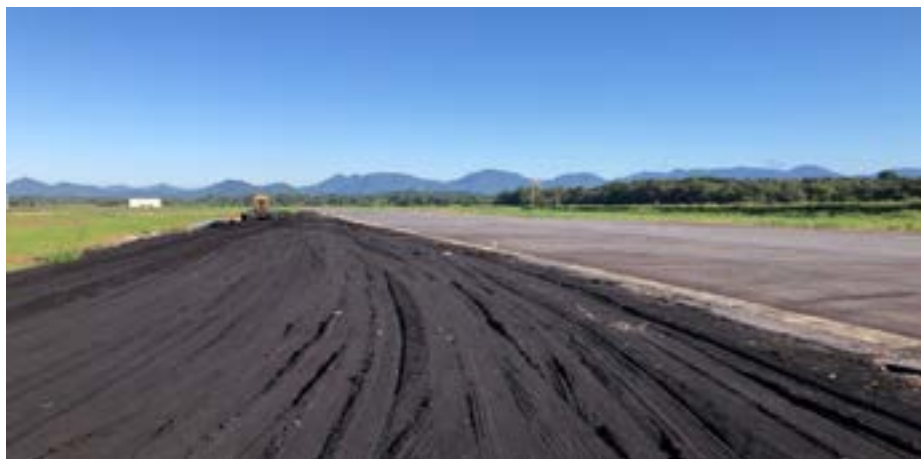
Figura 3 – Pista de um aeroporto em Santa Catarina, com ADF (CARNIN et al, 2025)
